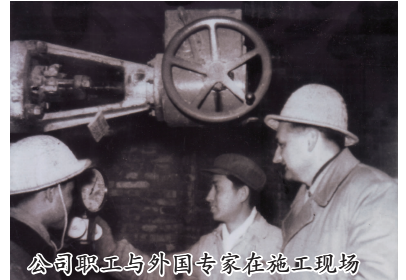
公司职工与外国专家在施工现场
